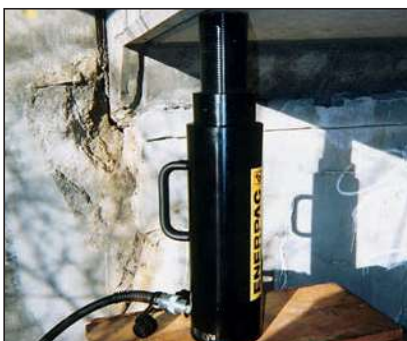
◀ Siirrettävää lukkomutterisylinteriä RACL-1506 käytetään lukittuna kuorman tukemiseen epoksiruiskutuksen aikana sillanvahvistuksessa.
